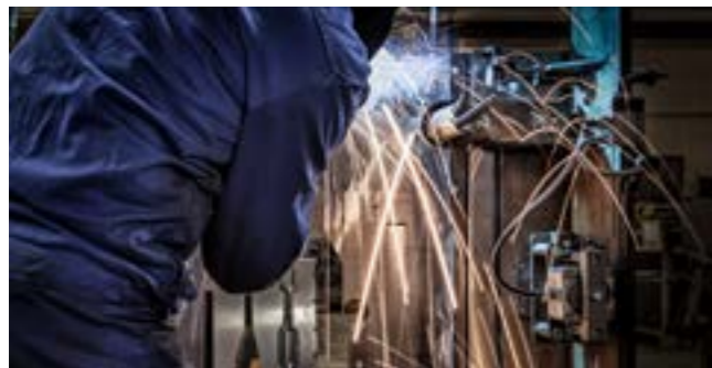
Saldatura del telaio
